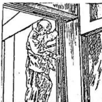
**Рис. 7. Установка стойки по отвесу**
