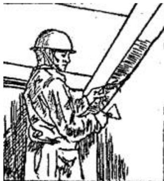
**Рис. 17. Нанесение гипсополимерцементного состава и разравнивание его шпателем**
