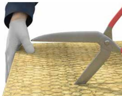
Использование ножниц для раскроя матов WIRED MAT. Позволяют нарезать изоляционный материал, покрытый гальванизированной стальной сеткой. Раскрой материала рекомендуется делать больше на 2-5 мм (в зависимости от плотности материала) от необходимого размера.
