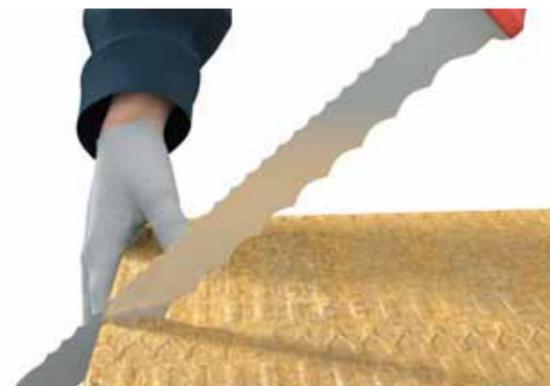
Использование ножа при раскройке изоляционных плит и матов ROCKWOOL. Изоляционные материалы ROCKWOOL легко подвергаются раскройке ножом. Раскрой материала рекомендуется делать больше на 2-5 мм (в зависимости от плотности материала) от необходимого размера.
