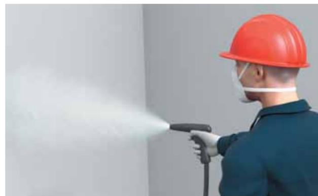
Нанесение антикоррозионного покрытия. Поверхность стальной конструкции должна быть покрыта антикоррозийным покрытием, принятым для данного проекта.
