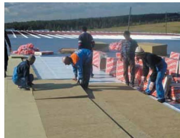
не менее 200 микрон. На пароизоляционный слой укладываются теплоизоляционные плиты из каменной ваты серии РУФ БАТТС, которые, в зависимости от проекта кровли, применяются в различных комбинациях. Теплоизоляционные плиты РУФ БАТТС должны укладываться в разбежку как по швам, так и по стыкам верхнего и нижнего слоев.
