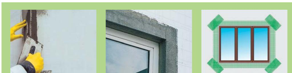
Все внешние углы здания усиливаем, утапливая угловой элемент с сеткой, в нанесенный клеевой раствор **weber.therm S100** или **weber.vetonit 410**.
