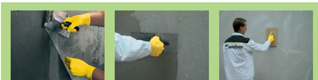
На поверхность наносим клеевой раствор **weber.therm S100** или **weber.vetonit 410** в него утапливаем фасадную щелочестойкую сетку **Vertex R131**. Сетку укладываем сверху вниз, вдавливая гладилкой из нержавеющей стали от центра к краям на глубину примерно 1/3 от толщины слоя. Полотна стеклосетки укладываются с минимальным перекрытием 100 мм.
